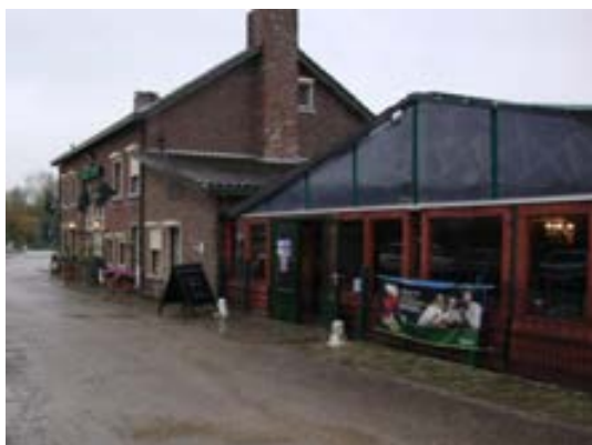
Tijdelijke voorziening voorzijde (Slakweg)
