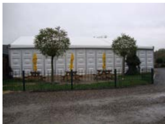
Tijdelijke voorziening achterzijde
